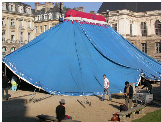
Montage d'un chapiteau (Rennes, 2007)
