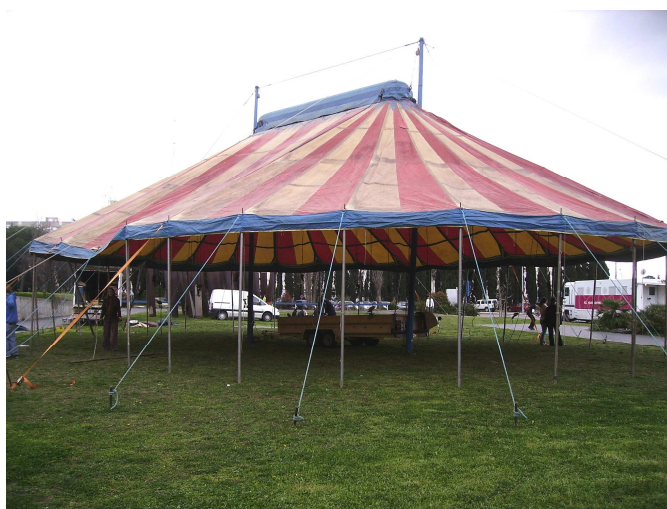
Chapiteau en cours de montage à Montpellier, 2008
